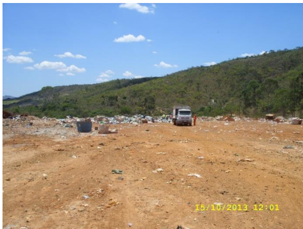
Figura 101 - Evidência da área de descarregamento de resíduos. Caminhão compactador de lixo descarregando no maciço de resíduos
