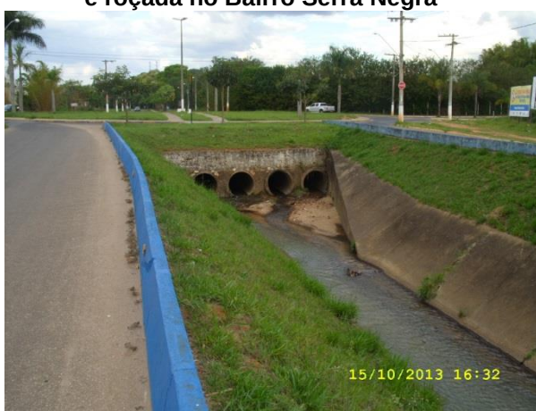
Figura 81 - Evidência do aspecto de limpeza das margens do Córrego Rangel (Av. José Amando Queiroz)
