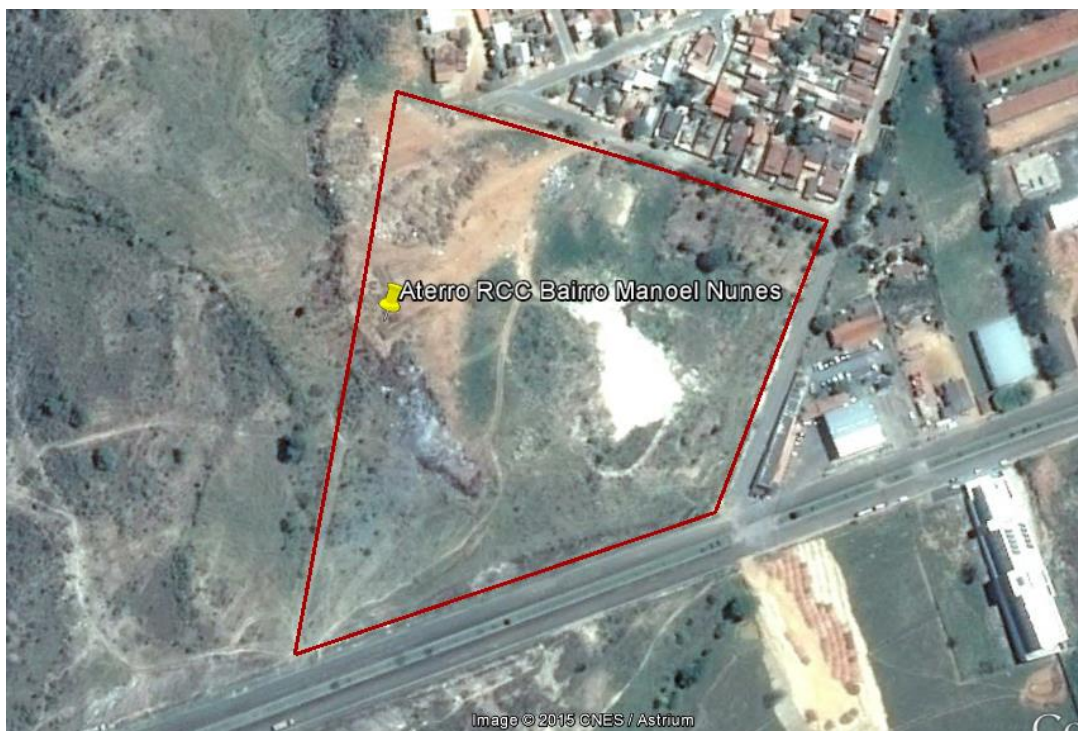
Figura 181 - Imagem Google Earth de área para aterro de RCC e volumosos do bairro Manoel Nunes
