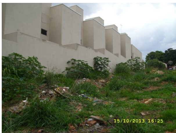
Figura 48 - Evidência de deposição clandestina de RCC em lotes vagos
