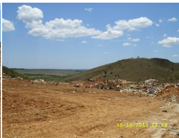
Figura 106 - Evidência de deposição de RCC dispostos na área do lixão para ser utilizado como material de recobrimento
