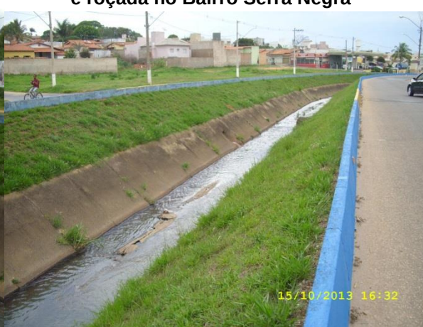
Figura 82 - Evidência do aspecto de limpeza das margens do Córrego Rangel (Av. José Amando Queiroz)
