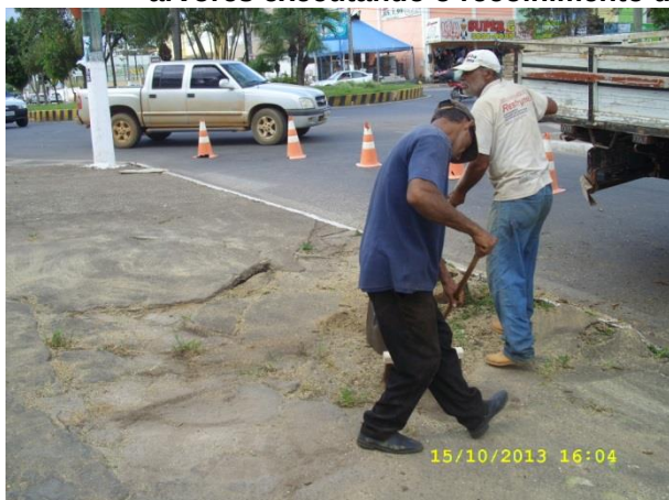
Figura 89 - Evidência da utilização de EPC (cones) pela equipe de poda
