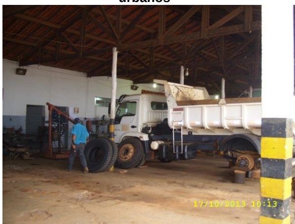
Figura 119 - Evidência da estrutura de oficina de manutenção de equipamentos
