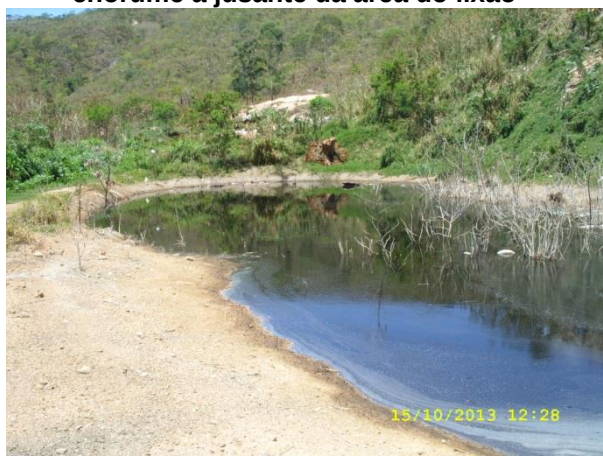
Figura 135 - Barragem de contenção de chorume a jusante da área do lixo
