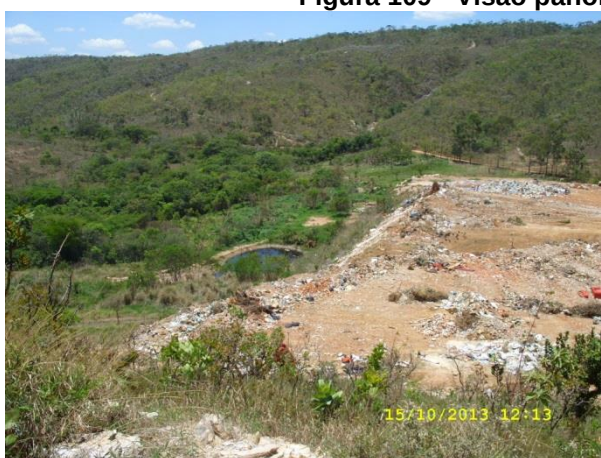
Figura 110 - Evidência do talude formado pelo maciço de resíduos (não ocorre compactação)
