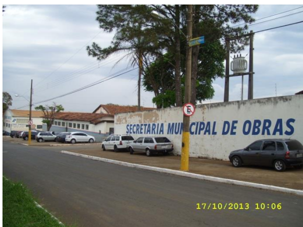
Figura 116 - Evidência da infraestrutura de apoio da Secretaria de obras e serviços urbanos
