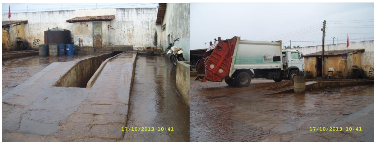
Figura 122 - Evidência da rampa de manutenção de equipamentos com caminhão compactador se posicionando para manutenção (lavagem e lubrificação)
