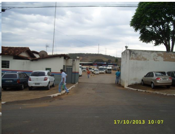
Figura 117 - Evidência da infraestrutura de apoio da Secretaria de obras e serviços urbanos
