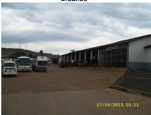
Figura 118 - Evidência do pátio de vigilância de equipamentos
