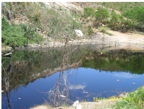
Figura 133 - Barragem de contenção de chorume a jusante da área do lixo
