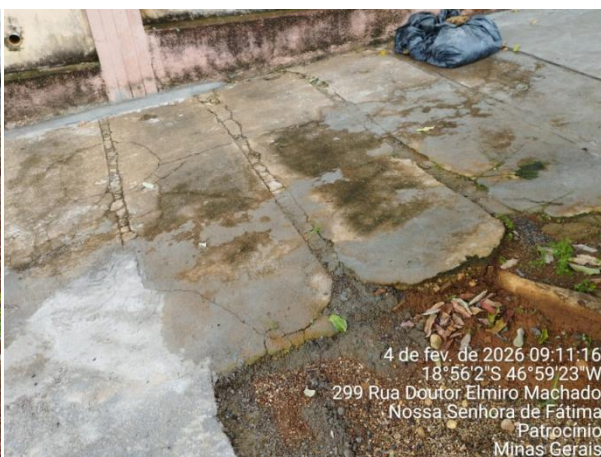
Foto 4: Trincas que se estendem até o muro.
