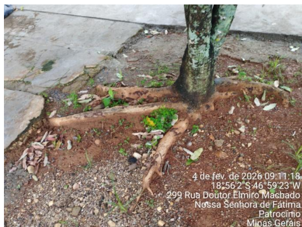
Foto 3: Raízes danificando a calçada.
