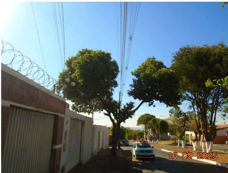
Foto 01: Oiti requerido para corte. Observa-se também galhos da lateral esquerda em contato com a rede elétrica e sobre a residência, além da poda em formato em V, resultando em distribuição desequilibrada dos galhos.
