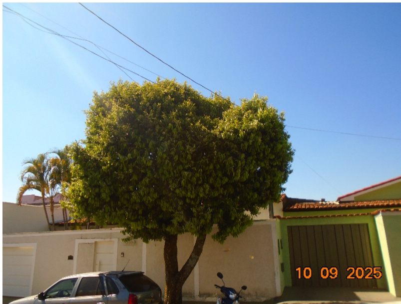
Foto 02: Observa-se o contato da copa com a rede elétrica.
