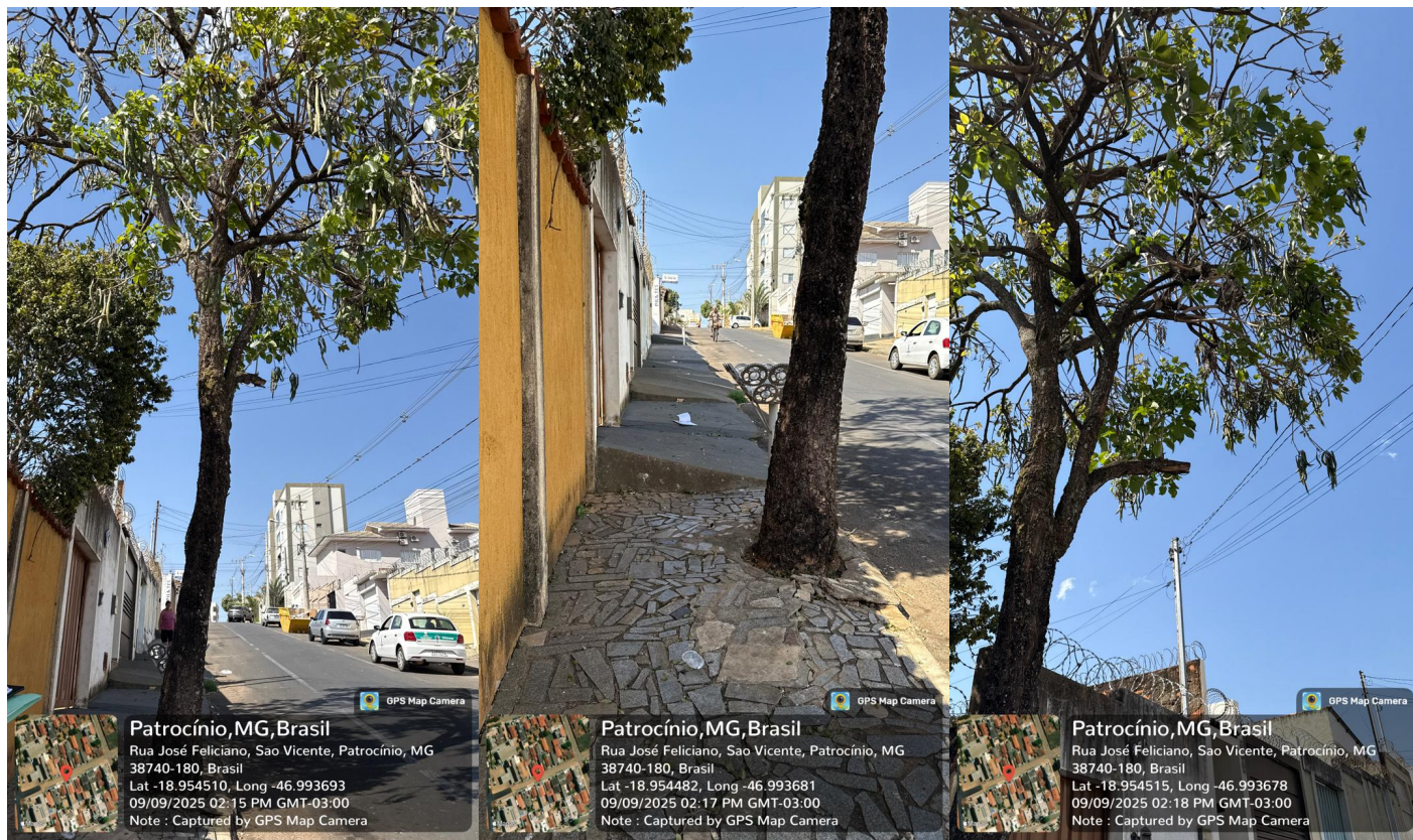
Foto 01: Ipê-rosa requerido para corte. Foto 02: Danos causados à calçada. Foto 03: Galhos encostando na rede elétrica
