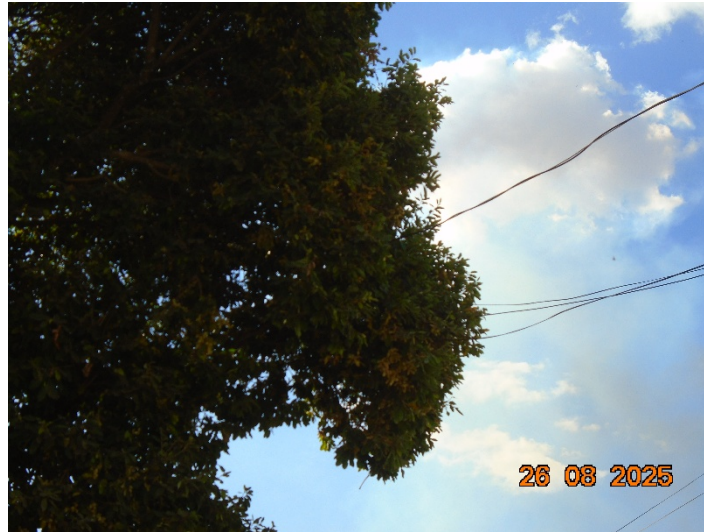
Foto 03: Galhos superiores na rede elétrica
