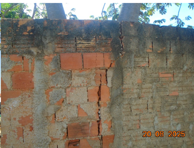
Foto 03: Observa-se os danos causados ao muro, como estufamento, comprometendo sua estabilidade. Foto 04: Rachaduras
