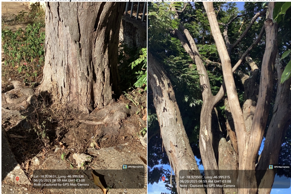
Foto 01 – Árvore Sibipiruna danificando o passeio a esquerda e copa da referida árvore à direita
