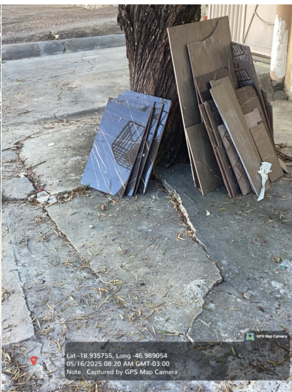
Foto 01 – Indivíduo arbóreo Calistemo à esquerda e rachaduras provocadas por suas raízes à direita
