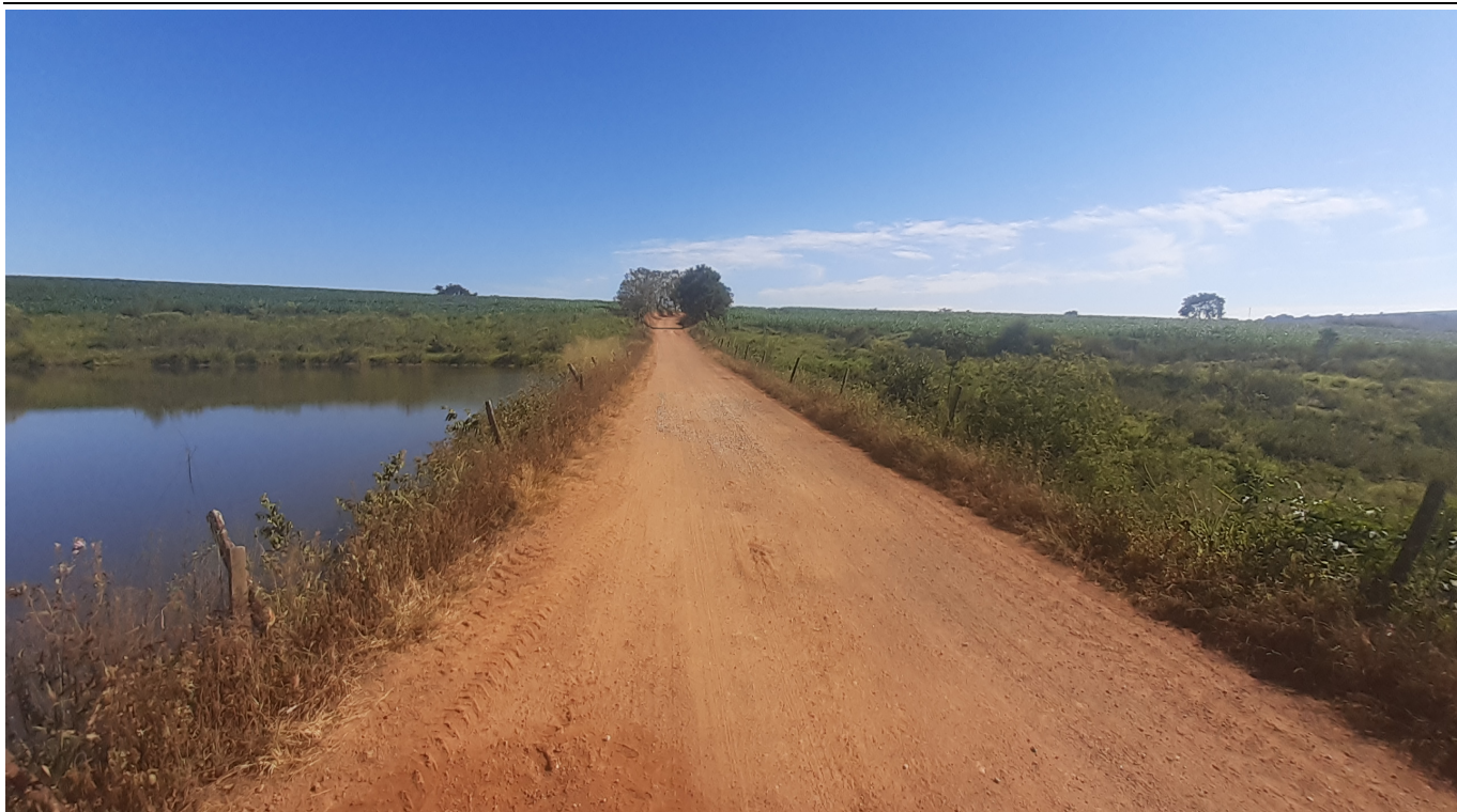
Figura 10. Vista da crista do barramento conservada, sem trincas e rachaduras no local.
