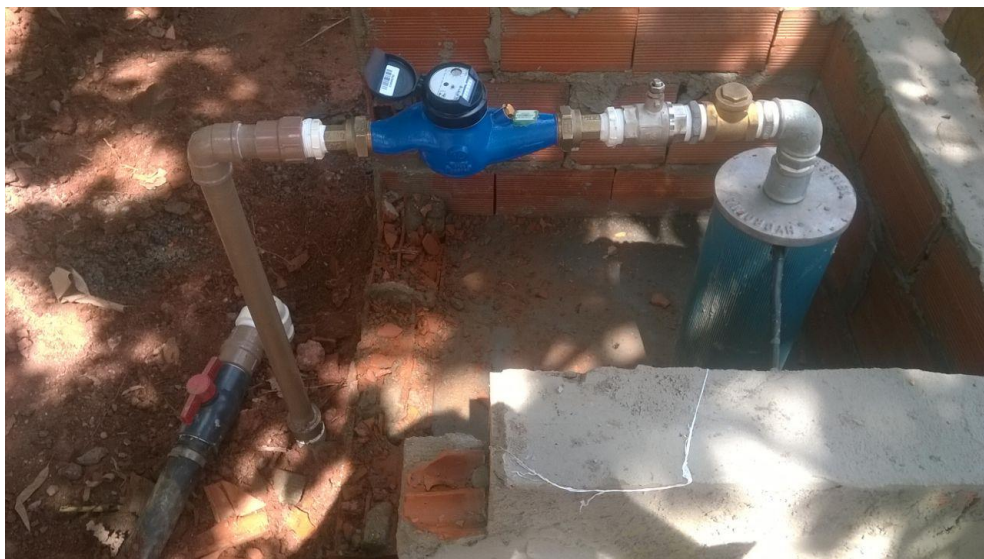
Figura 12. Detalhes do ponto de captação de água subterrânea da Fazenda Bom Jardim I.
