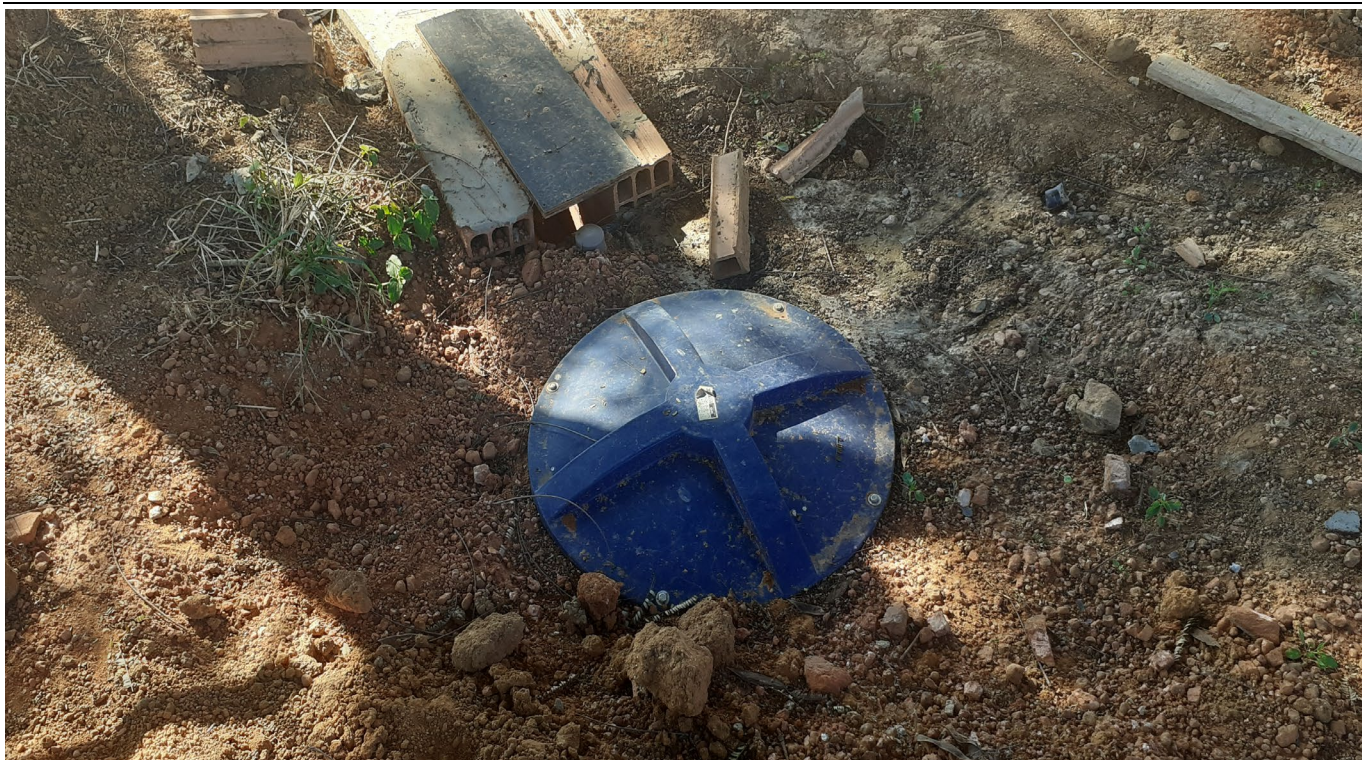
Figura 26. Sistema de tratamento de efluentes sanitários que deverá ser instalado em todos os sanitários do empreendimento.
