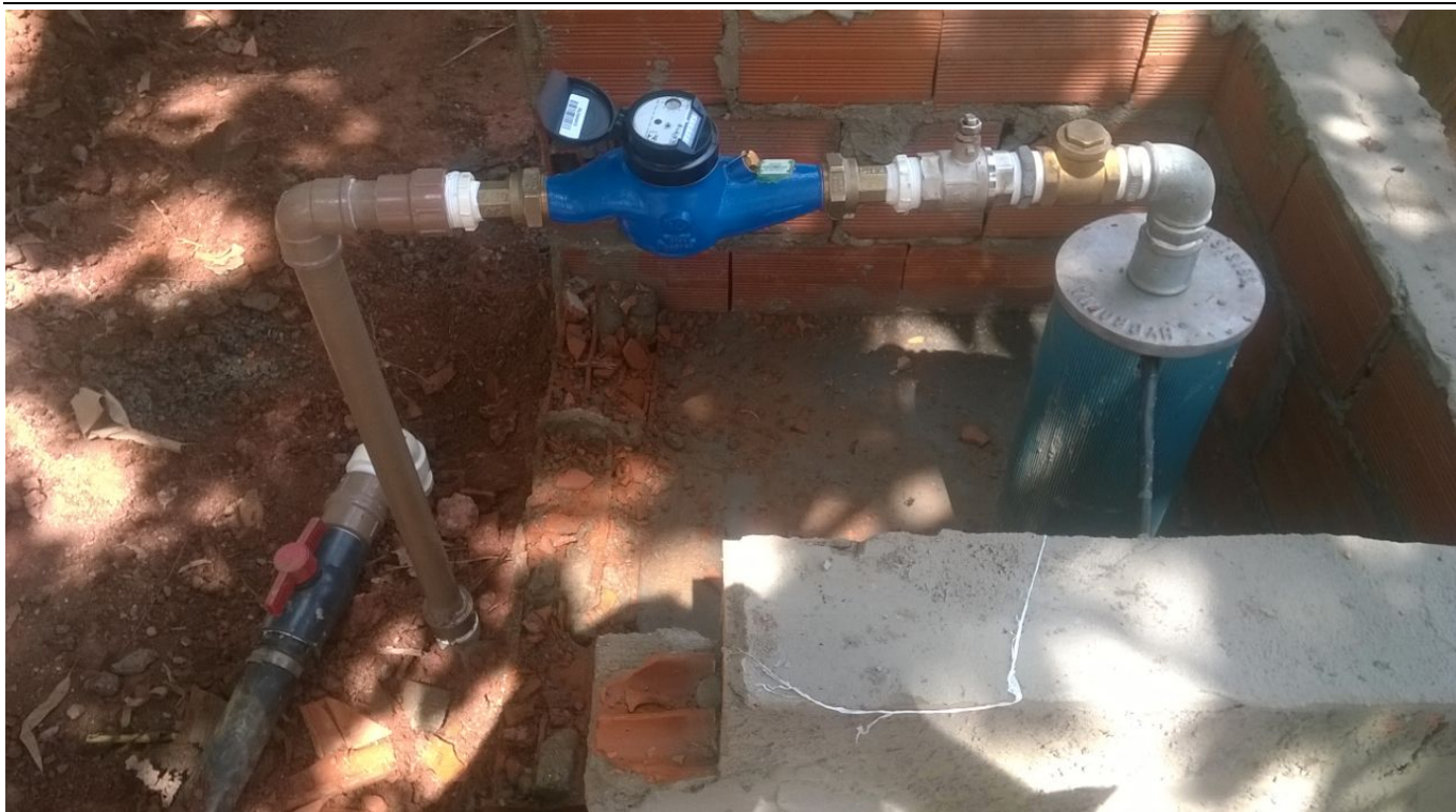
Figura 04. Detalhes do ponto de captação de água subterrânea da Fazenda Bom Jardim I.
