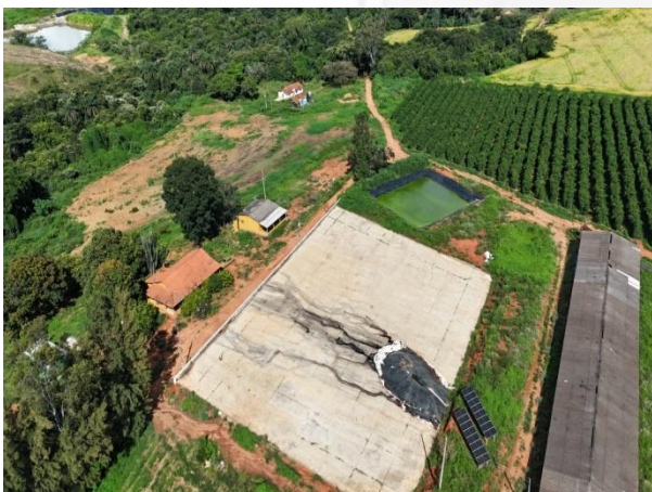
Foto 5: Terreirão e lagoa de estabilização.
