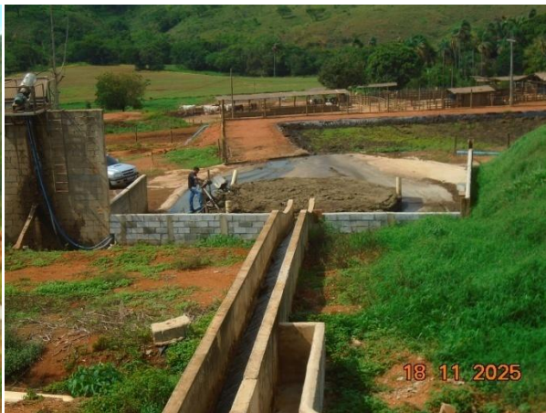
Foto 6: Lagoa de estabilização.
