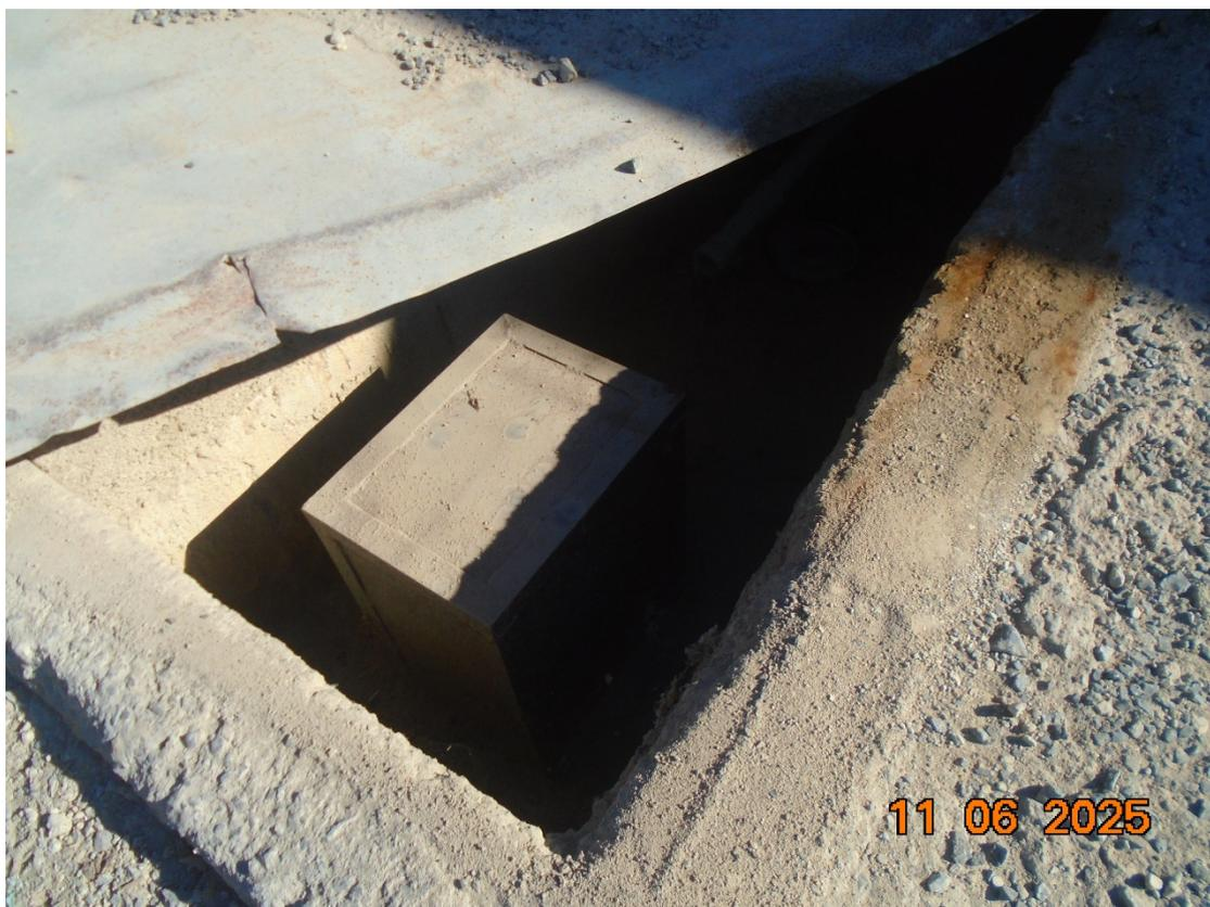
Foto 08: Poço tubular desativado
