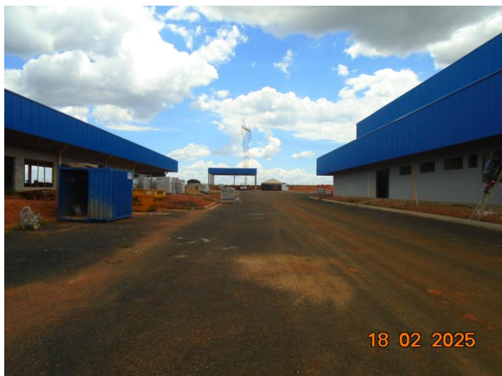
Foto 3: Registro fotográfico das instalações
