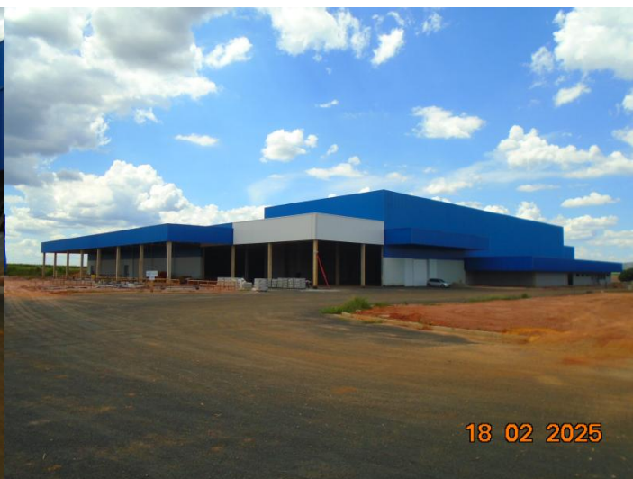
Foto 4: Registro fotográfico das instalações
