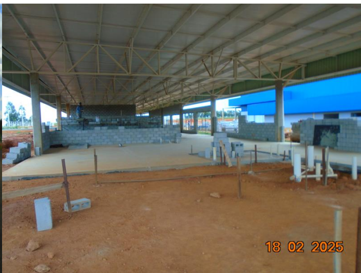
Foto 2: Portaria/vestiários sendo construídos
