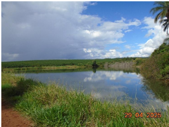
Foto 02: Barragem de irrigação
