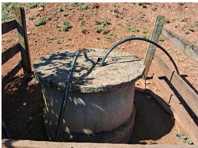
Fotografias 09 e 10: Captações subterrânea (esquerda) e superficial (direita).
