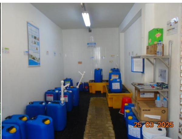
Foto 4: Depósito de produtos químicos.
