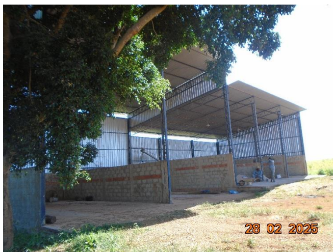
Foto 06: Benfeitoria – Galpão para armazenamento de ração
