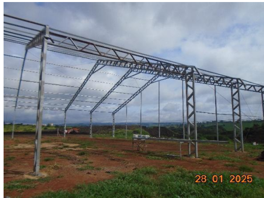
Foto 02: Novo barracão em construção
