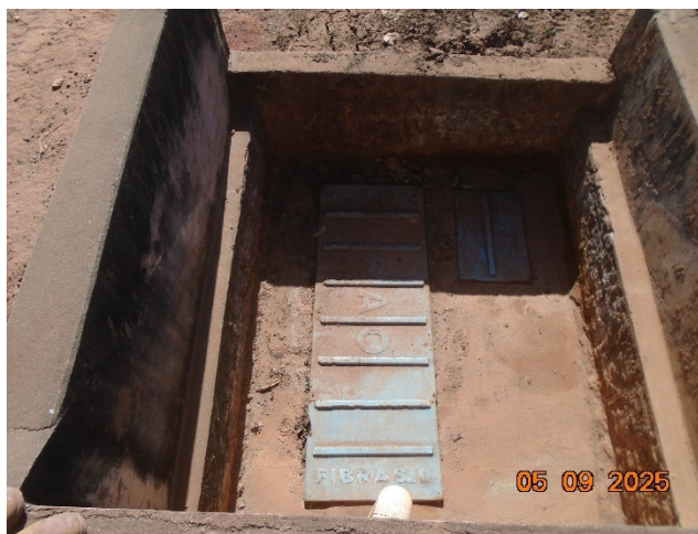
Foto 3: Caixa separadora de água e óleo
