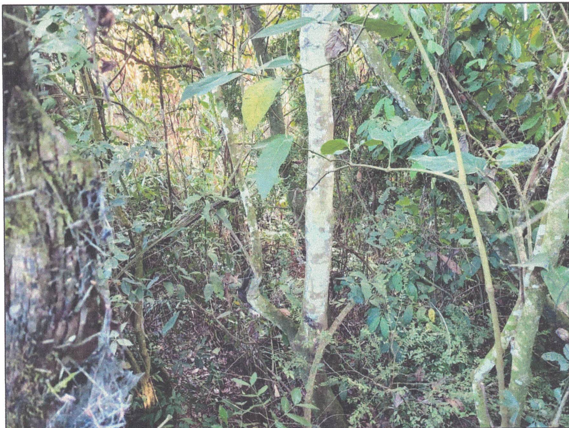
Figura 9. Fotografia evidenciando trecho com a presença de indivíduos arbóreos e arbustivos no aterro da barragem, Patrocínio - MG.
