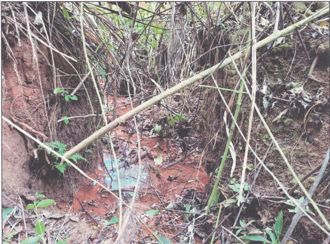
Figura 6. Fotografia evidenciando canais preferenciais de percolação da água do aterro, Patrocínio – MG.
