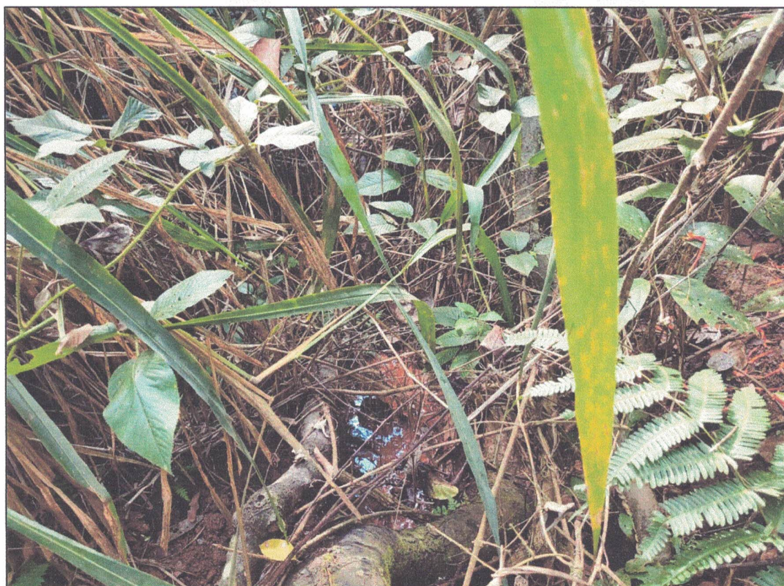
Figura 8. Fotografia evidenciando canais preferenciais de percolação da água do aterro, Patrocínio – MG.
