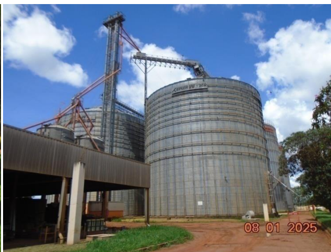
Foto 2 –Silo de aerados de estocagem de grãos
