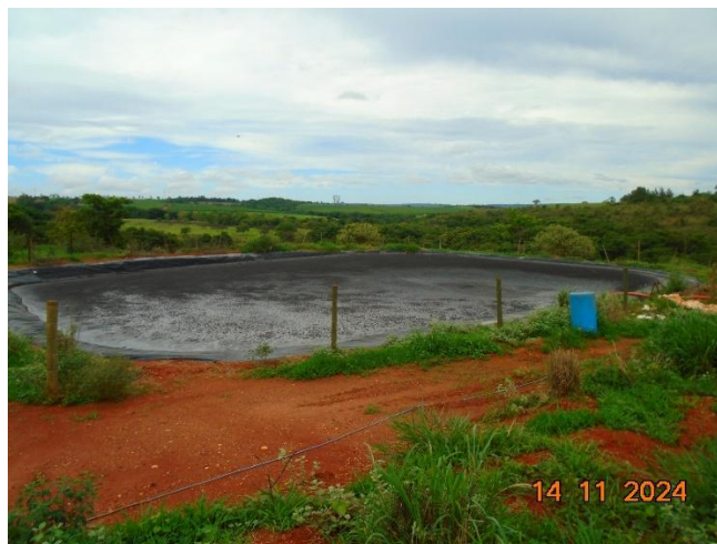
Figura 02: Sistema de tratamento de dejetos suínos
