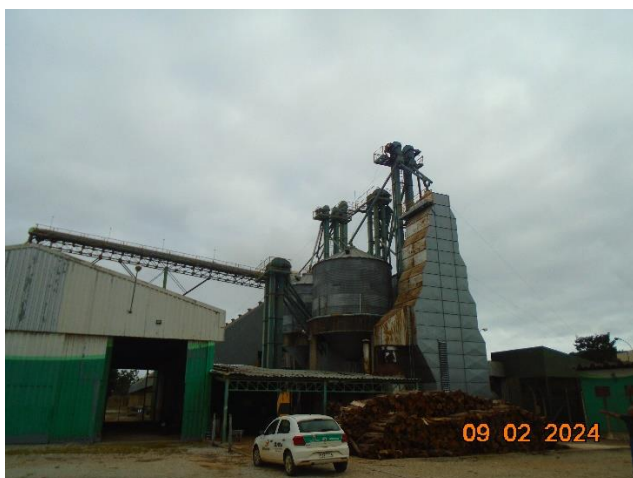
Foto 03: Infraestrutura de beneficiamento
