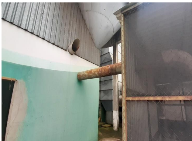
Fotos 09 e 10: Sistema de captação de particulados
