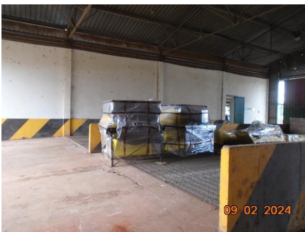
Foto 04: Interior do barracão - moegas
