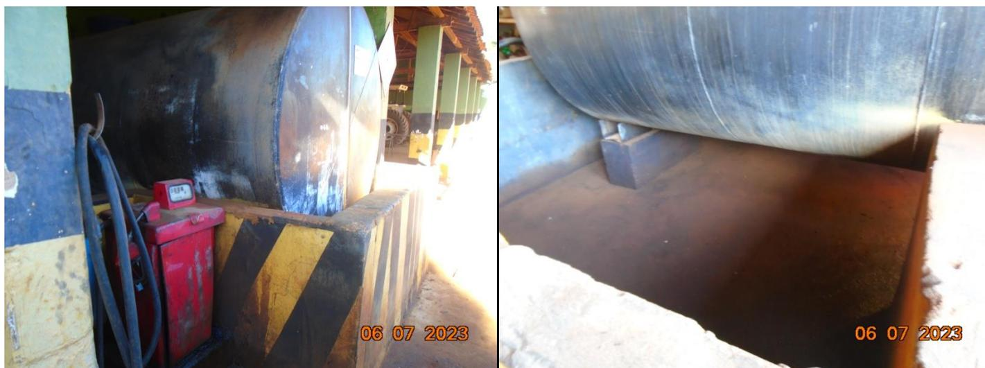
**Figura 12 - Ponto de abastecimento em área impermeabilizada com bacia de contenção**
