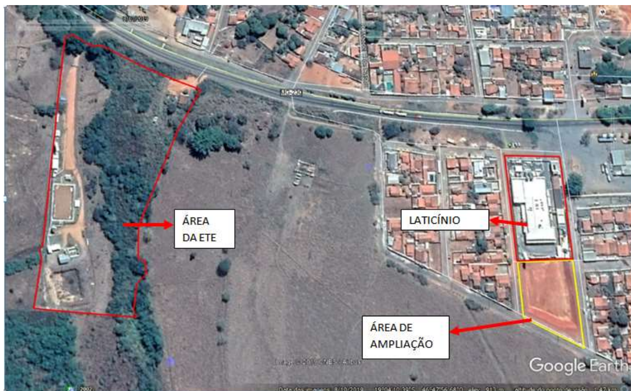
Figura 1: vista geral do empreendimento e área da sua ETE
