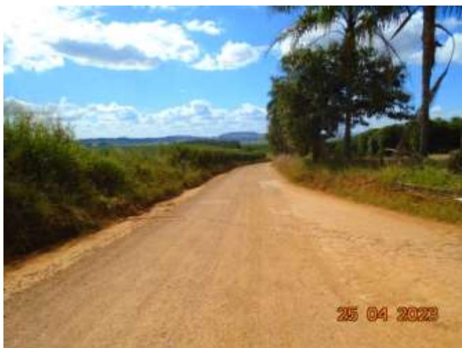
Figura 01: Vista da estrada.
