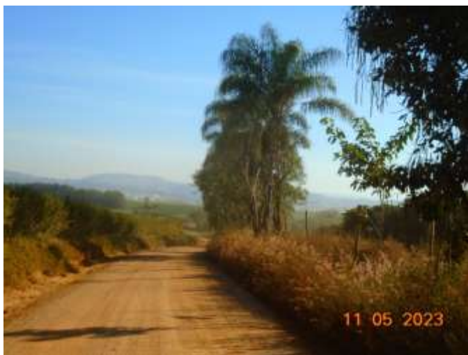
Figura 03: Vista da estrada.
