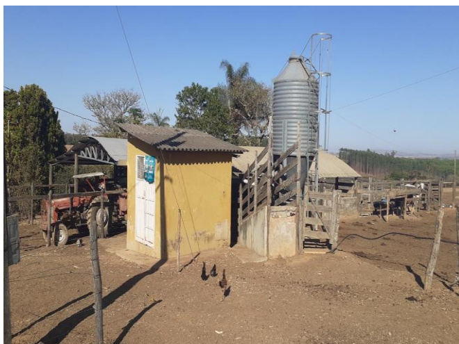
Foto 03: Benfeitorias – curral e depósito
