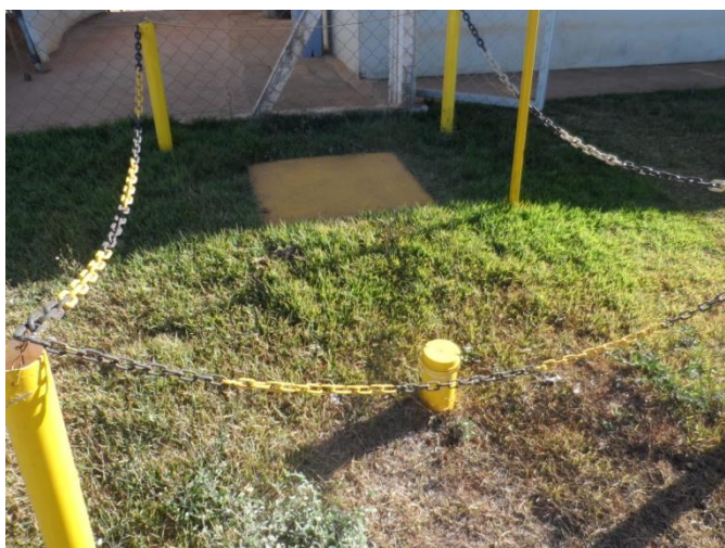
Foto 01: Fossa séptica com sumidouro
