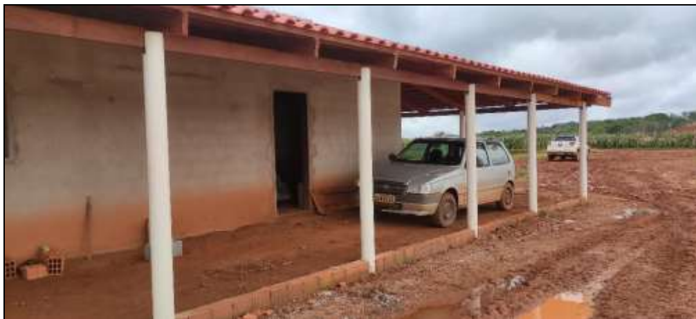
Figura 08: Casa-sede em construção
