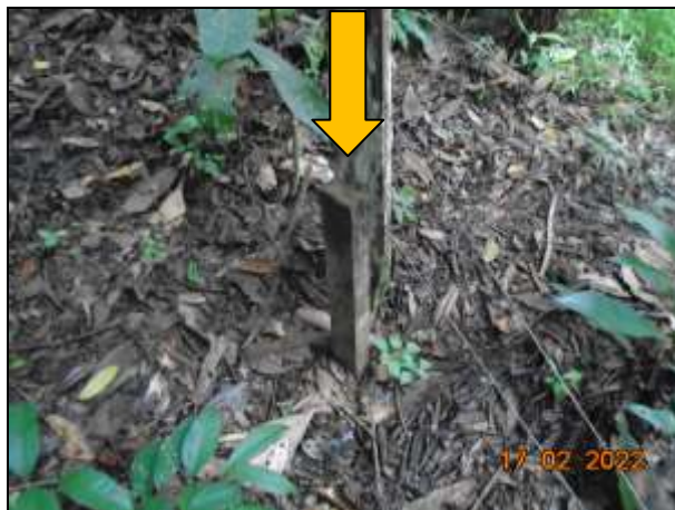
Figura 11: Observar ponto do aterro para a travessia de um dos lados do curso d'água com marcação de estaca
