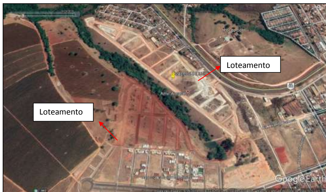
Figura 1: imagem aérea total do loteamento após iniciarem as obras – setembro de 2019.
