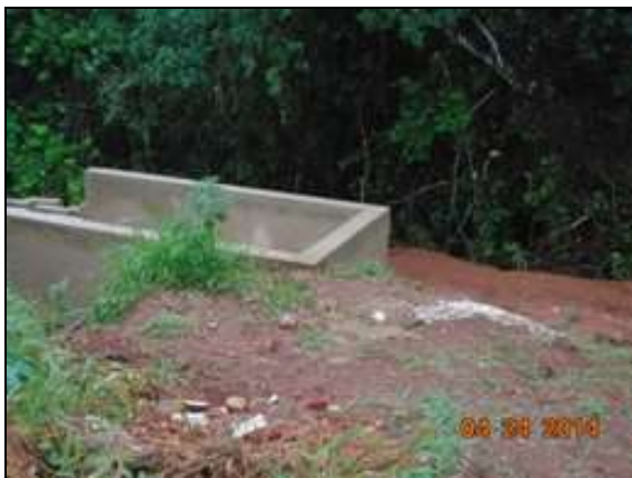
Figuras 17 e 18: Obra de um dos dissipadores em APP
