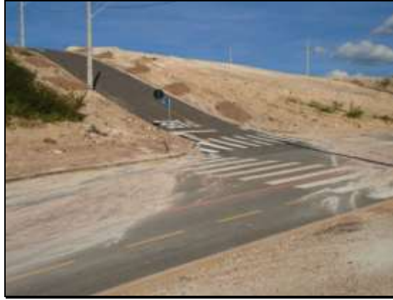
Figuras 9 e 10: Áreas mais íngremes, quadras 20 e 21, processo de escoamento superficial ocasionando erosões
