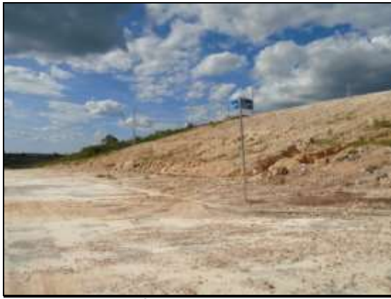
Figuras 9 e 10: Áreas mais íngremes, quadras 20 e 21, processo de escoamento superficial ocasionando erosões
