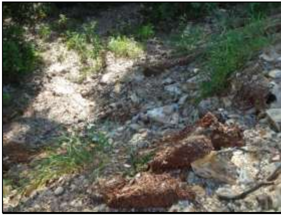
Figuras 15 e 16: Erosão no talude dos lotes da parte mais baixa: 464, 454, 443 e 477 e obras em andamento. Na figura 16 é já uma obra recente de implantação de canaleta para coletar parte do escoamento superficial.
