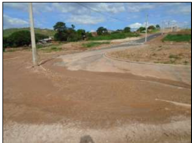
Figuras 13 e 14: detalhes dos processos de escoamento superficial e assoreamento junto as regiões com cotas mias baixas
