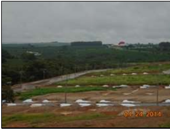
Figuras 21 e 22: implantação de mantas protetoras para evitar carreamento de solo e para realizar cacimbas nas quadras
