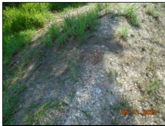
Figuras 23 e 24: Processos erosivos nos taludes e algumas medidas de contenção realizadas. Foto 21 uma biomanta de fibra de côco que foi implantada nos taludes da APP para auxiliar tanto na contenção do solo como na fixação da grama.
