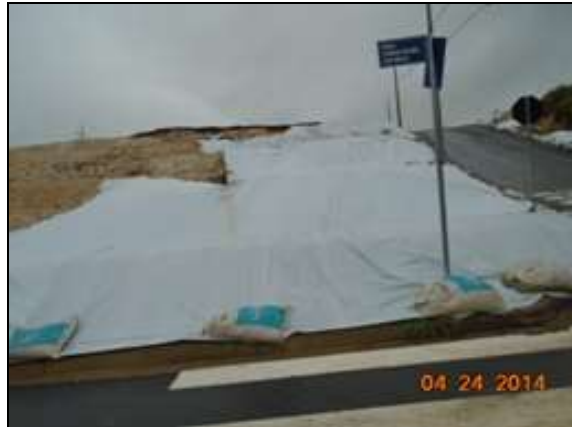
Figuras 19 e 20: implantação de mantas protetoras para evitar carreamento de solo e para realizar cacimbas nas quadras.
