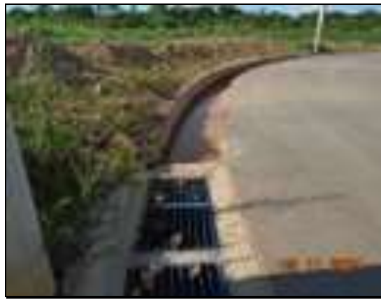
Figuras 15 e 16: Erosão no talude dos lotes da parte mais baixa: 464, 454, 443 e 477 e obras em andamento. Na figura 16 é já uma obra recente de implantação de canaleta para coletar parte do escoamento superficial.
