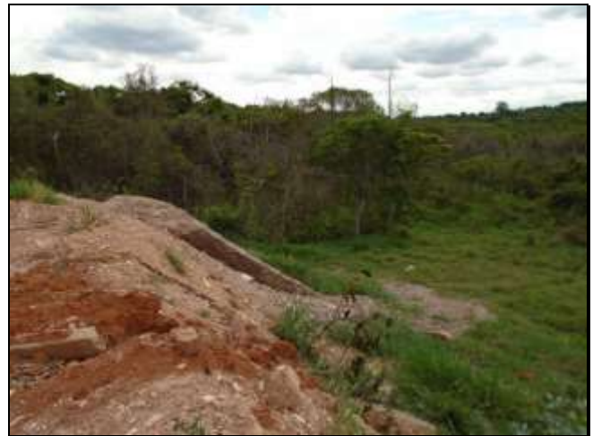
Figuras 11 e 12: taludes dos lotes com problemas de estabilidade: lotes 443, 454, 464 e 477
