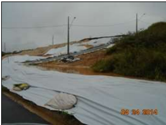
Figuras 19 e 20: implantação de mantas protetoras para evitar carreamento de solo e para realizar cacimbas nas quadras.
