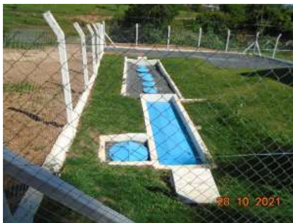
Figura 02: Bag de acondicionamento de resíduos
