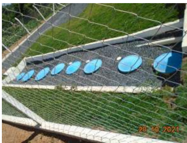
Figura 04: Local de pequenos reparos
