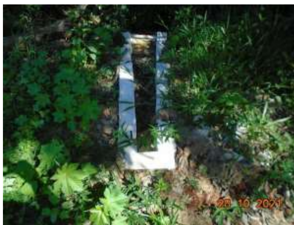
Figura 06: Poço manual (cisterna)
