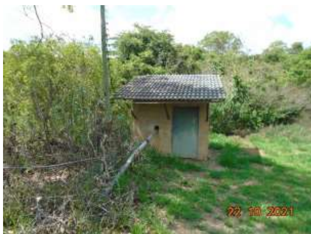
Figura 11: Casa de bombas
