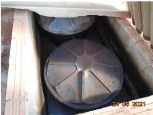
Figura 07e 08: Caixa separadora de água e óleo
