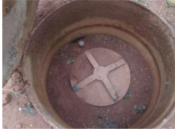
Fotos 11 e 12: Biodigestores para tratamento de efluentes sanitários
