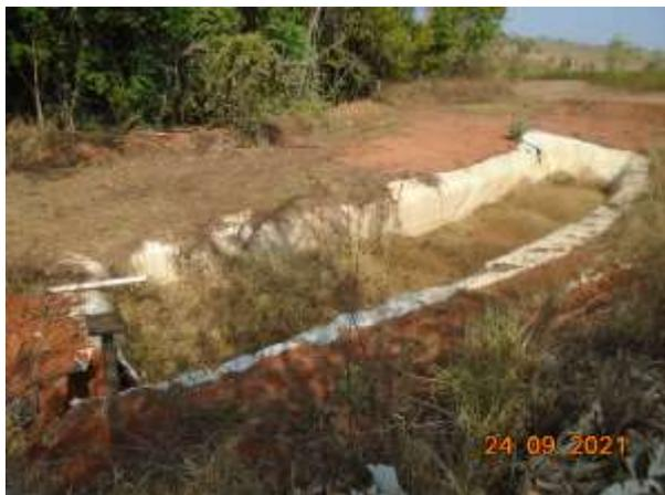
Foto 14: Bacia para contenção de água pluvial do terreirão
