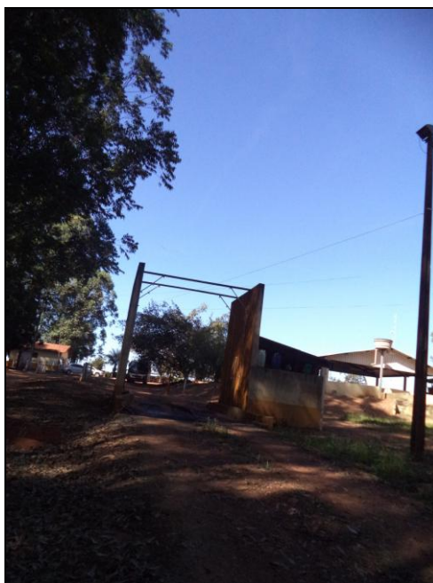
Figura 08: Arco de desinfecção prévia de veículos e caminhões antes do seu acesso à granja
