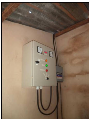
Figura 05: Horímetro poço tubular da portaria
