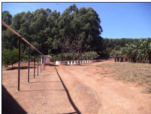
Figura 23: Observar tubulação aérea que direciona o efluente ao tratamento Figura 24: Tanque de equalização dos efluentes
