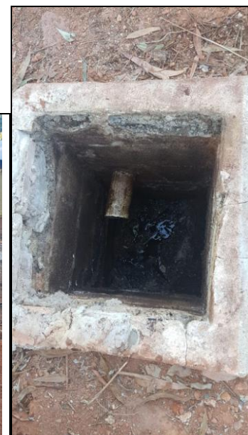
Figuras 20 e 21: Vista externa e interna, respectivamente, da caixa de coleta do chorume que percola das células de compostagem e é direcionado para a Estação de Tratamento de Efluentes
