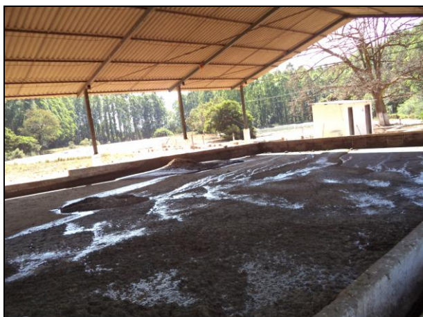
Figuras 26 e 27: Pátio de compostagem com cobertura e mureta de contenção.
