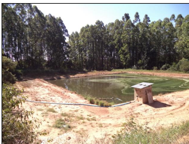
Figuras 33 e 34: Observar que a lagoa de polimento não apresenta revestimento, além da intensa coloração esverdeada e da formação de espuma na sua superfície
