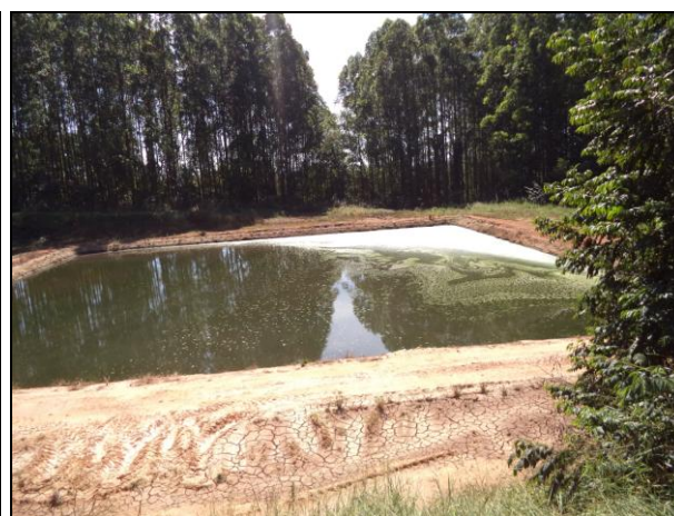
Figuras 33 e 34: Observar que a lagoa de polimento não apresenta revestimento, além da intensa coloração esverdeada e da formação de espuma na sua superfície
