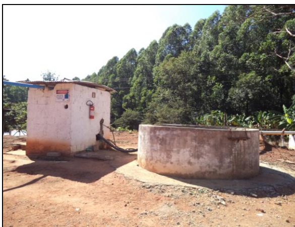
Figura 23: Observar tubulação aérea que direciona o efluente ao tratamento Figura 24: Tanque de equalização dos efluentes
