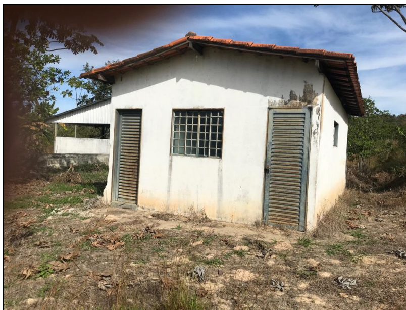
Figura 48: Escritório inativado – Antigo setor de quarentena
