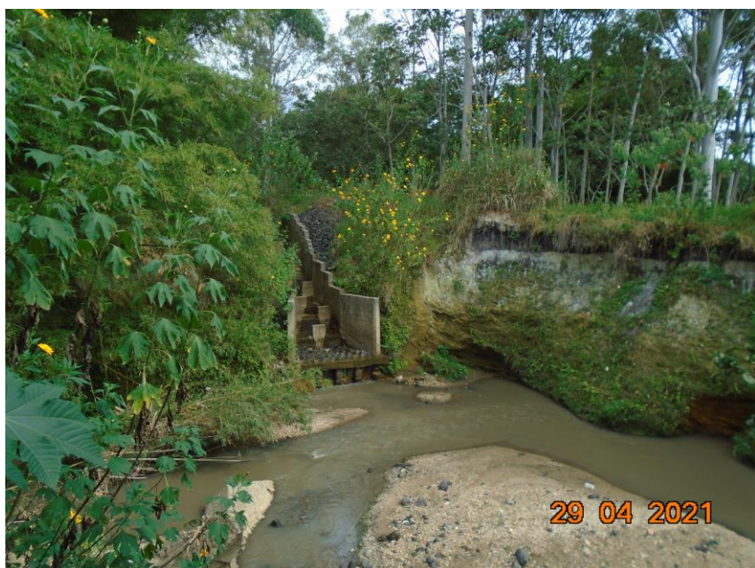
Figura 5: local da segunda travessia para a Ete Rangel
