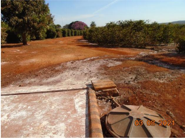
Foto 07: Observar extravasamento de efluente
