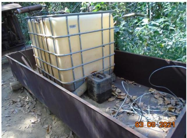
**Foto 16:** Armazenamento de óleo diesel para abastecer motor
