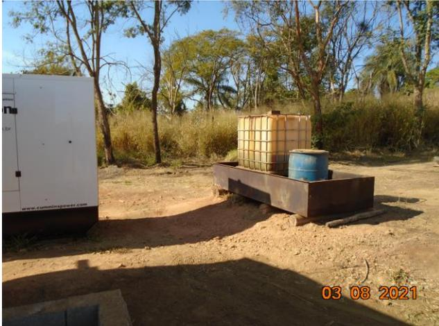
**Foto 13:** Armazenamento de óleo diesel para abastecer gerador
