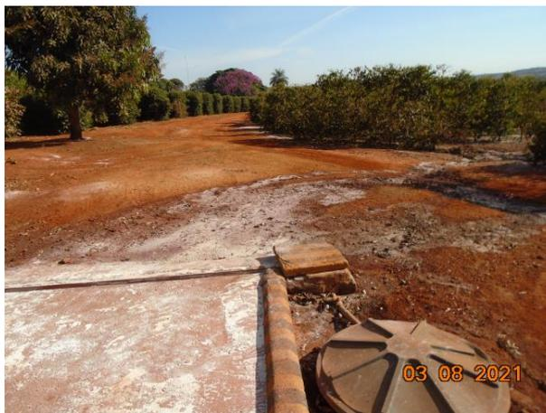
**Fotos 1 e 2:** Extravasamento de efluente da pista de preparo da calda de pulverização.
