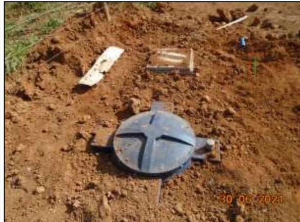
**Figura 10:** Biodigestor
