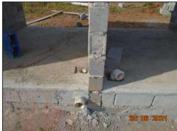
**Figura 14:** Observar tubulações de condução do chorume a ser gerado na composteira e conduzido até as lagoas
