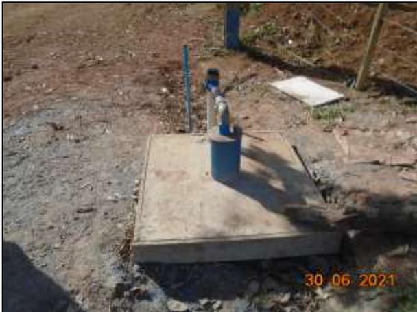
**Figura 09:** Poço tubular
