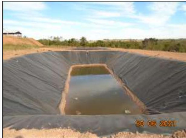
**Figura 12:** Em detalhe, lagoa com revestimento
