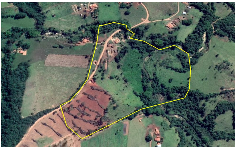
Figura 02: Vista aérea da segunda área do empreendimento. Fonte: Google Earth Pro
