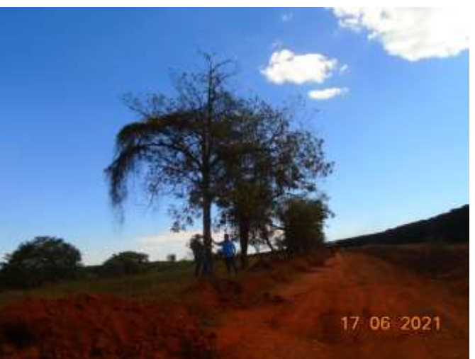
Figura 06: Estrada objeto das obras
