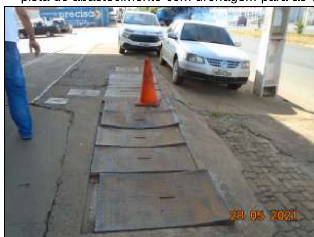
Figuras 20 e 21: Caixas Separadoras de Água e Óleo (CSAO)
