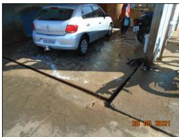
Figuras 12 e 13: Lavador de veículos leves. Observar canaletas no entorno do lavador, cobertura e impermeabilização do solo
