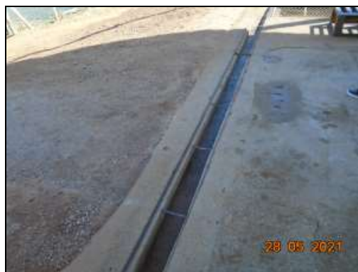
Figuras 10 e 11: Sistema de drenagem do efluente à CSAO
