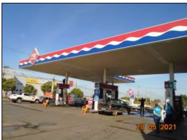
Figura 02: Vista da pista de abastecimento
