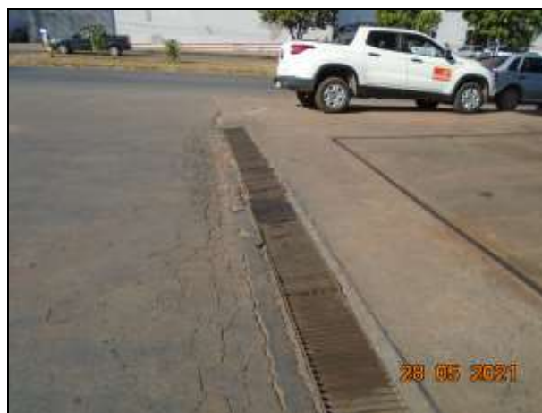
Figura 19: Observar grelha para drenagem pluvial
