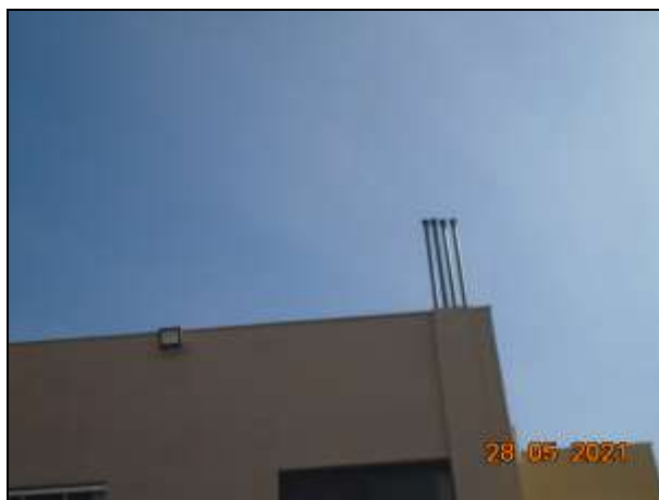
Figuras 39 e 40: Suspiros dos tanques aparentes – Dois deles sob a cobertura da pista de abastecimento
