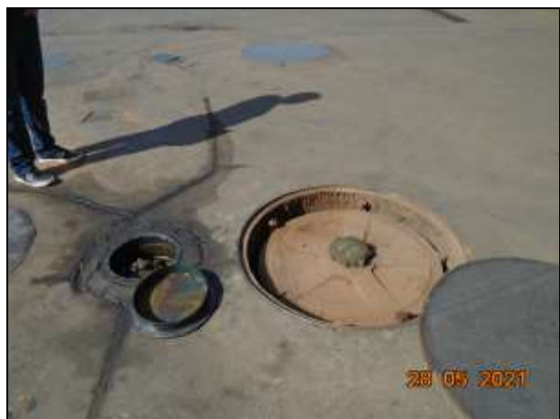
Figuras 34 e 35: Câmara de acesso à boca de visita do tanque
