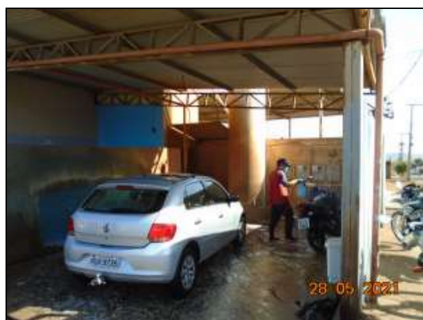
Figuras 12 e 13: Lavador de veículos leves. Observar canaletas no entorno do lavador, cobertura e impermeabilização do solo
