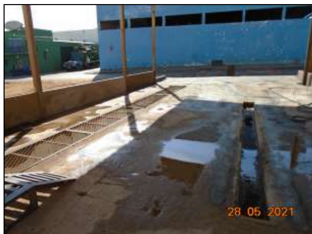
Figuras 10 e 11: Sistema de drenagem do efluente à CSAO
