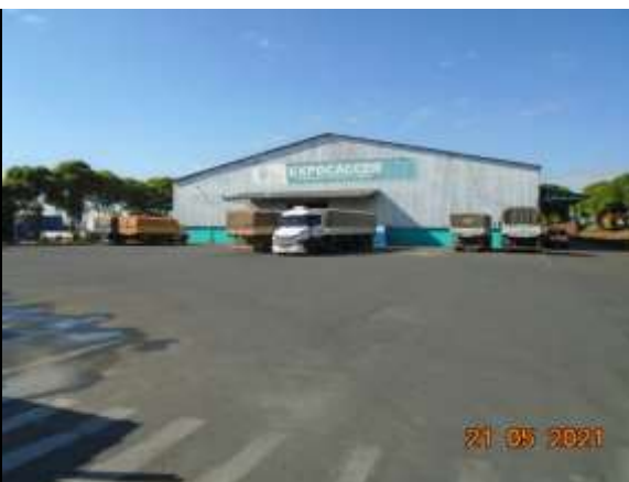
Foto 12: Pátio de estacionamento
