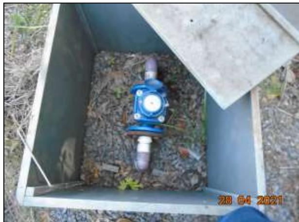
**Figura 02:** Poço tubular com hidrômetro
