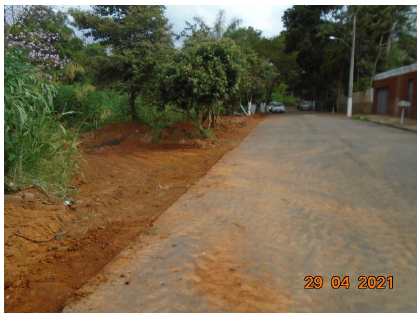
Figuras 3: local da construção da EEE da Rua Riacho do Ipiranga
