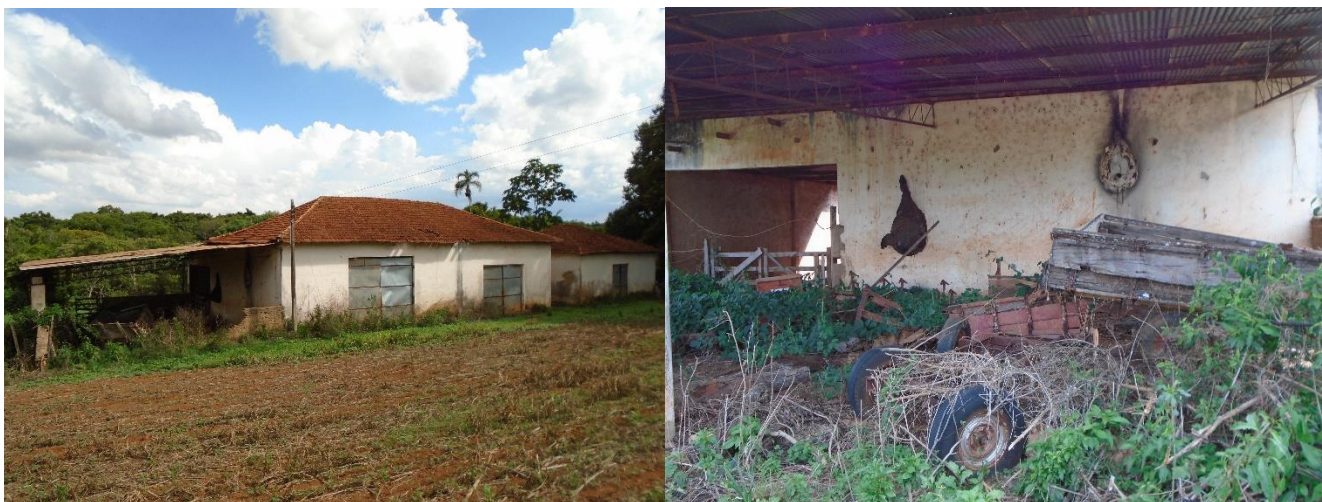
Fotos 1 e 2: Benfeitorias em estado de abandono
