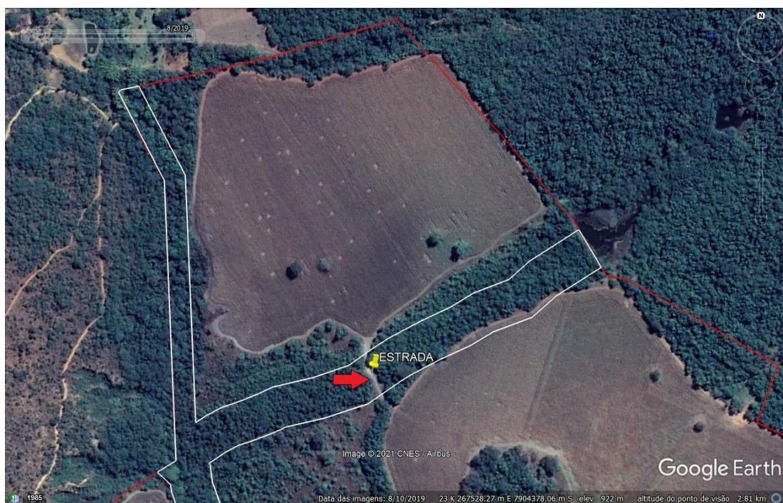
Figura 6: Estrada em Área de Preservação Permanente indicada pela seta.
