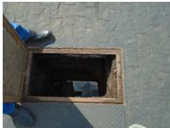
Figuras 08 e 09: canaleta em volta da área do lavador de veículos, direciona o fluxo para CSAO
