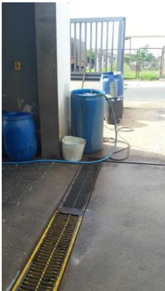
Figuras 08 e 09: canaleta em volta da área do lavador de veículos, direciona o fluxo para CSAO
