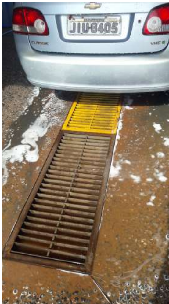
Figuras 08 e 09: canaleta em volta da área do lavador de veículos, direciona o fluxo para CSAO
