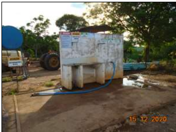
Figuras 37 e 38: Local de realização de tripla lavagem de embalagens. Observar derramamento de efluentes no solo devido ao fato da pista estar inadequada, sem muretas corretamente dimensionadas, entre outros fatores
