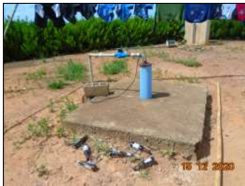
Figura 12: Poço tubular
