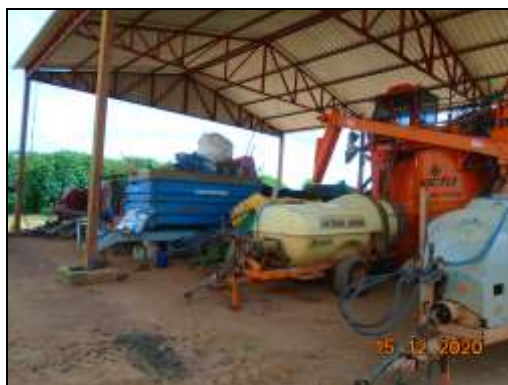
Figura 45: Barracão de máquinas. Observar ausência de impermeabilização
