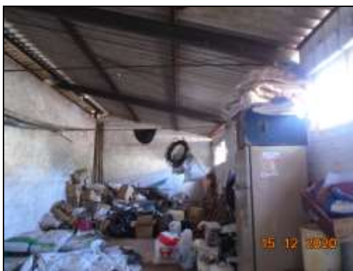
Figuras 34, 35 e 36: Vista externa e interna dos depósitos de agrotóxicos
