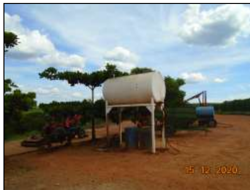
Figura 43: Ponto de abastecimento de combustíveis
