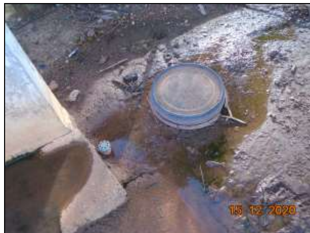
Figuras 37 e 38: Local de realização de tripla lavagem de embalagens. Observar derramamento de efluentes no solo devido ao fato da pista estar inadequada, sem muretas corretamente dimensionadas, entre outros fatores
