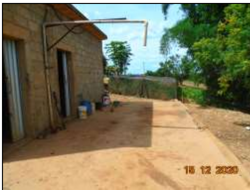
Figura 48: Pista de preparo da calda. Observar mureta na lateral, impermeabilização do solo.
