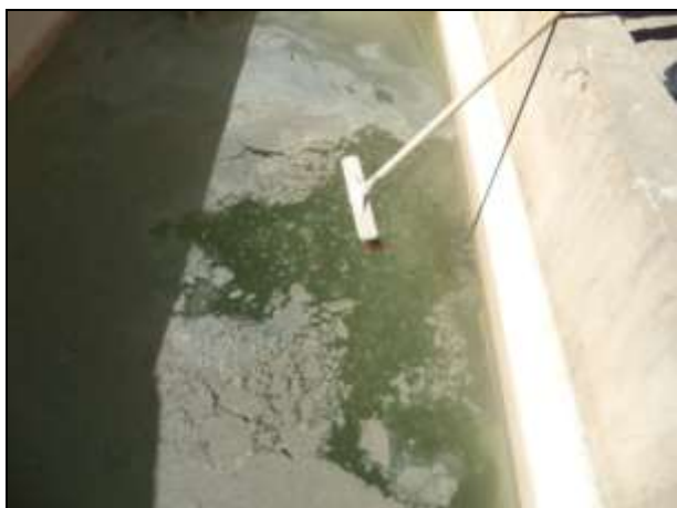
Figura 20: Repartição da CSAO após a separação da qual a água servida é reaproveitada. Observar partículas de sílica na sua superfície desprendidas da areia
