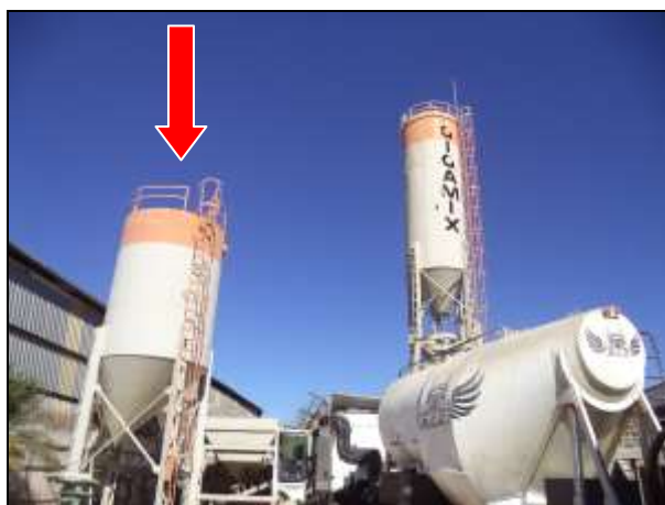
Figura 13: Reservatório de água
