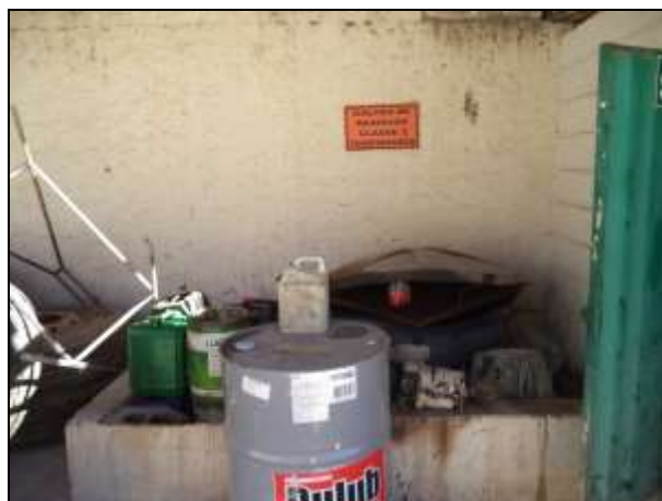
Figura 21: Armazenamento de vasilhames classe I Observar mureta de contenção no entorno
