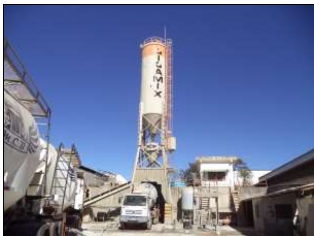
Figura 10: Usina de concreto
