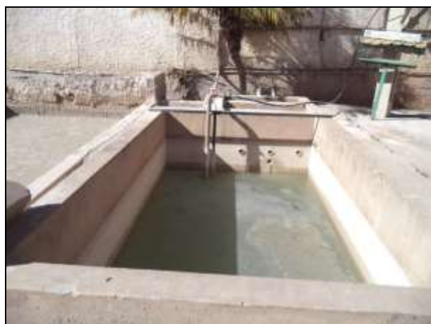
Figura 18: Vista da CSAO
