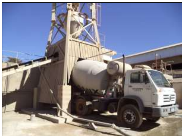
Figura 14: Betoneira sendo carregada com concreto
