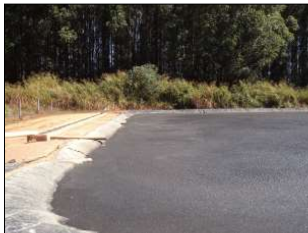
Figuras 31 e 32: Lagoas de tratamento de efluentes, sendo 02 anaeróbias, 02 facultativas e 01 de maturação. Observar, através das imagens, que a manta de PEAD das mesmas apresentava boas condições de revestimento
