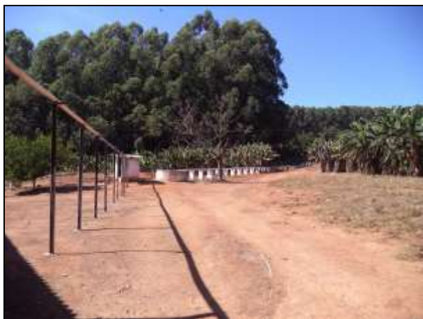
Figura 23: Observar tubulação aérea que direciona o efluente Figura 24: Tanque de equalização dos efluentes
