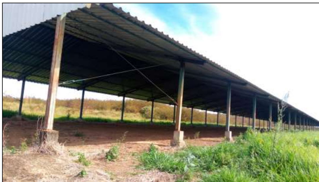
Figura 51: Galpão 2 – Sítio II da Granja São José dos Talhados
