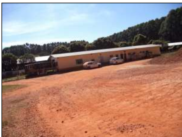
Figura 11: Vista externa do Setor Administrativo
