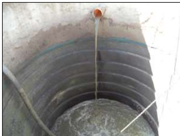
Figura 25: Em detalhe, vista interna do tanque de equalização
