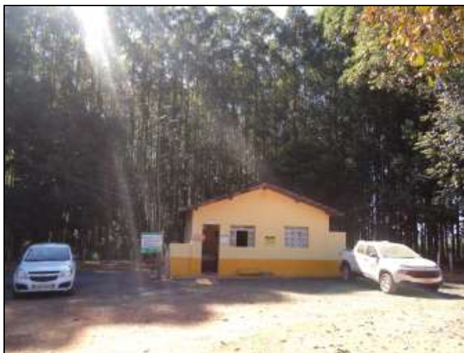
Figura 02: Vista da portaria do empreendimento. Observar “cortina verde” aos fundos da portaria, constituída por eucaliptos
