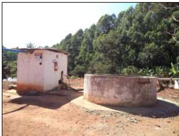
Figura 23: Observar tubulação aérea que direciona o efluente Figura 24: Tanque de equalização dos efluentes
