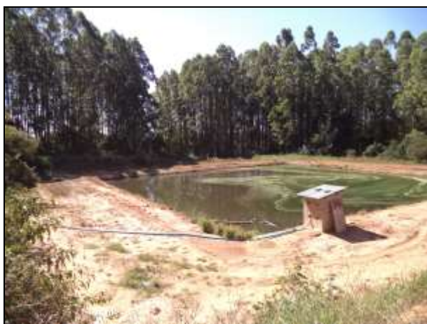
Figuras 33 e 34: Observar que a lagoa de polimento não apresenta revestimento, além da intensa coloração esverdeada e da formação de espuma na sua superfície
