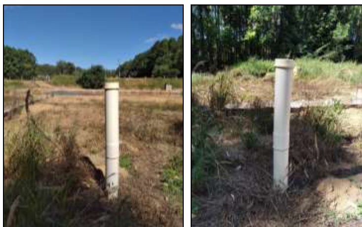
Figuras 37 e 38: Dois poços de monitoramento das águas subterrâneas à jusante do tratamento
