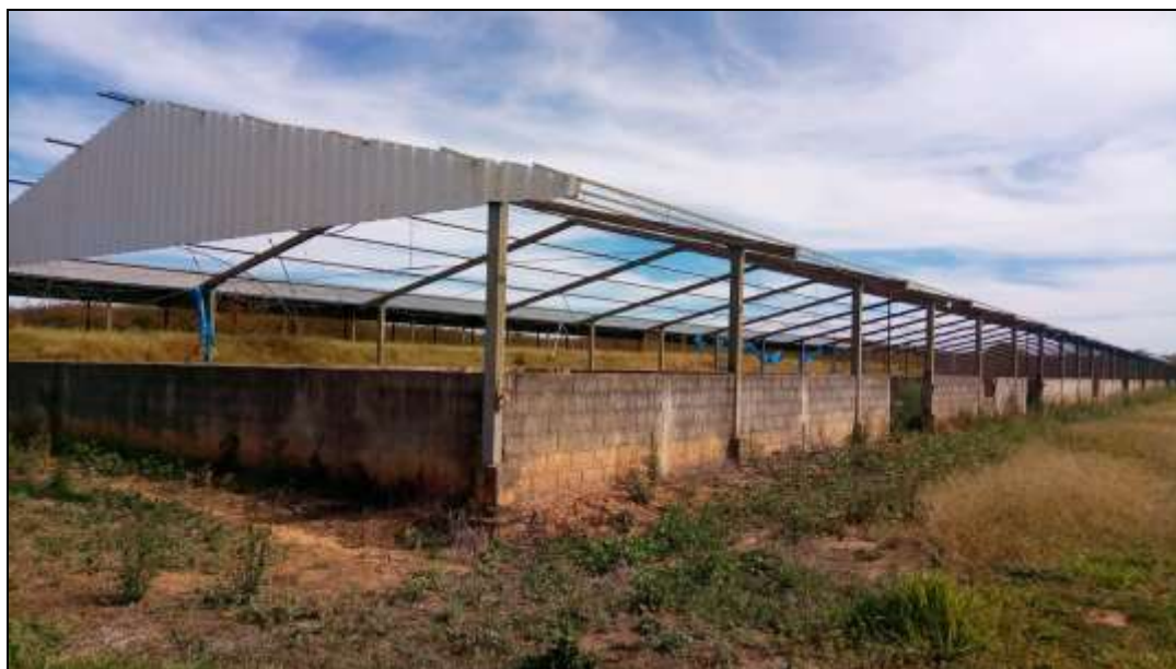
Figura 50: Galpão 1 – Sítio II da Granja São José dos Talhados
