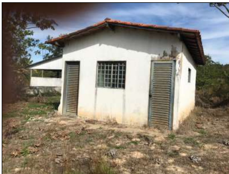
Figura 48: Escritório inativado – Antigo setor de quarentena
