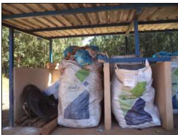
Figura 06: Local de armazenamento temporário, dotado de cobertura e impermeabilização, dos resíduos sólidos gerados em bags
