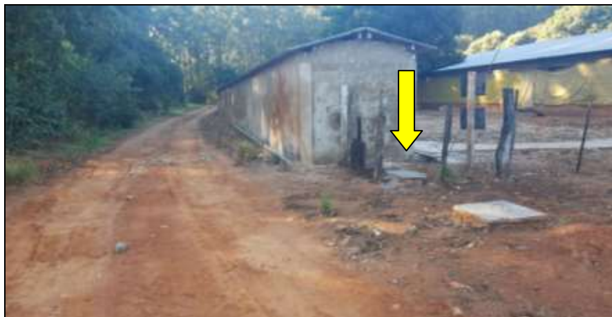
Figuras 20 e 21: Vista externa e interna, respectivamente, da caixa de coleta do chorume que percola das células de compostagem e é direcionado para a Estação de Tratamento de Efluentes
