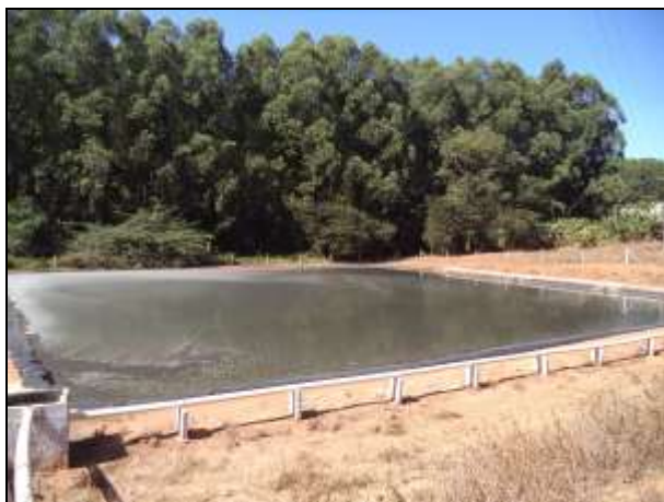
Figuras 31 e 32: Lagoas de tratamento de efluentes, sendo 02 anaeróbias, 02 facultativas e 01 de maturação. Observar, através das imagens, que a manta de PEAD das mesmas apresentava boas condições de revestimento
